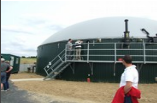
Unité de méthanisation liquide, infiniment mélangée
